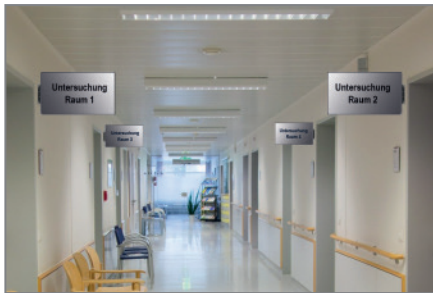
Installation von der Wand in den Raum
